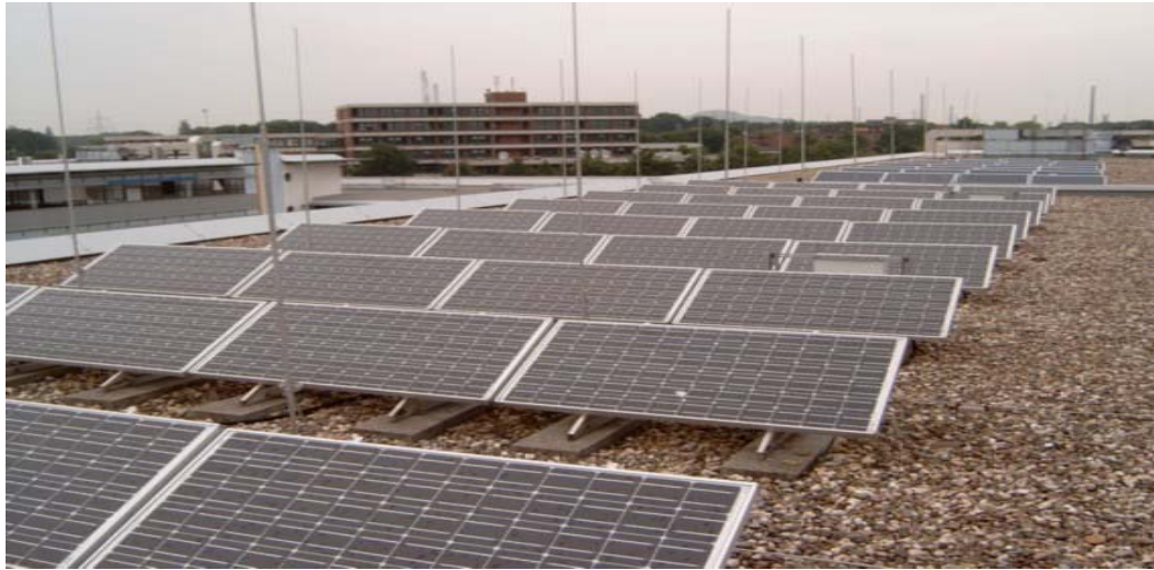
Figure 1 PV System F.H. Gelsenkirchen
